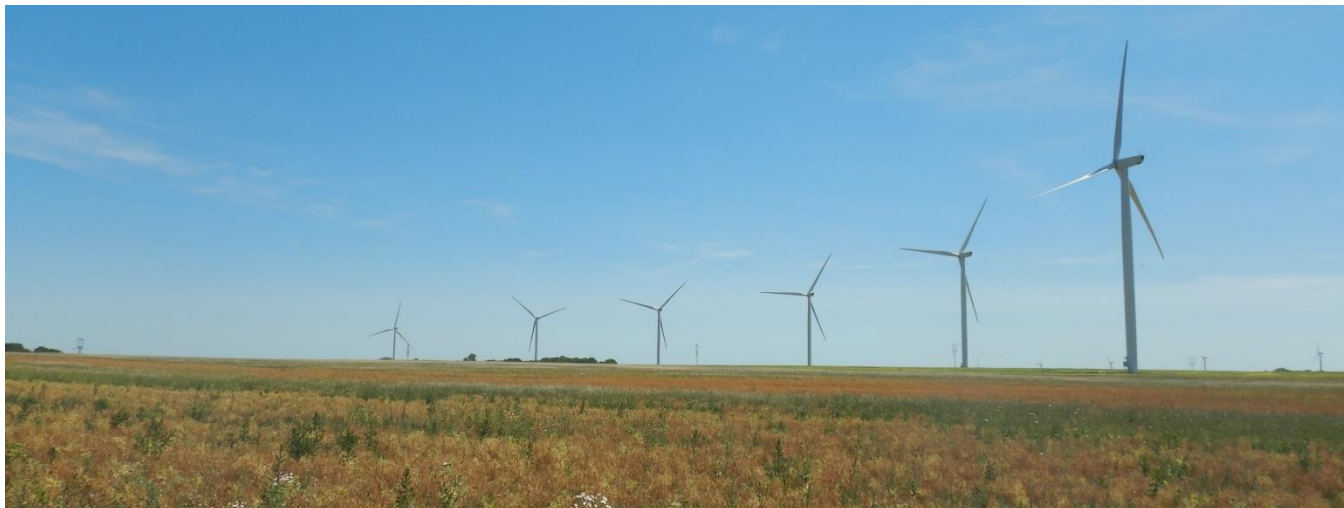
Photo 13 : éoliennes du parc de REUILLY et DIOU Énergies au nord de la zone du projet
