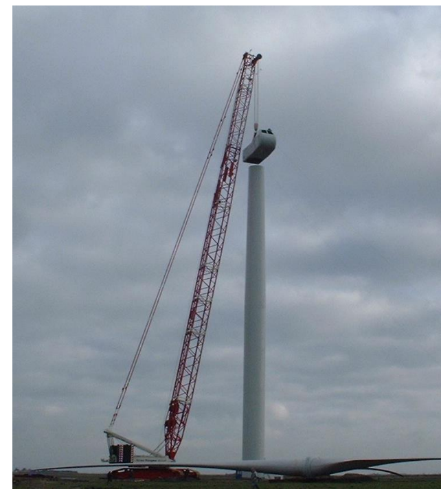
Montage de la nacelle
