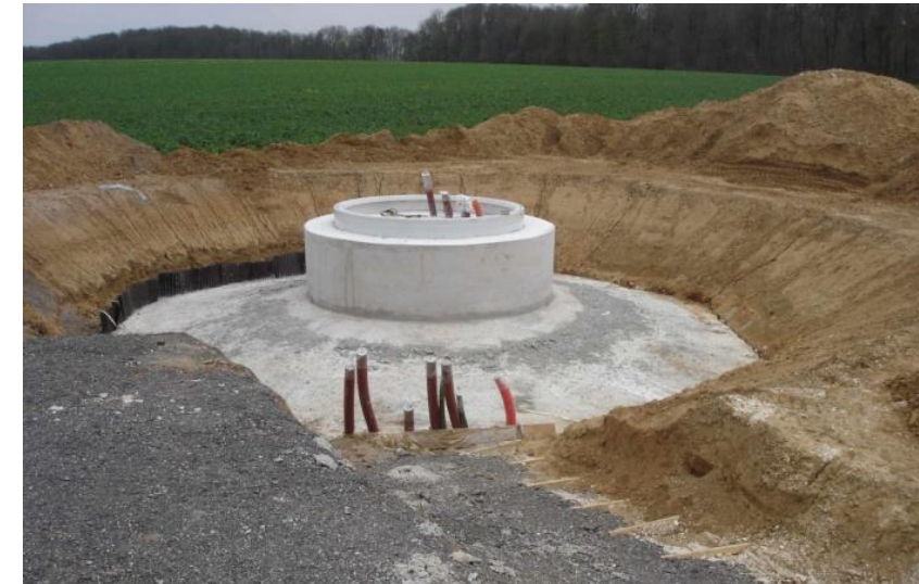
Photo 21 : fondation d'éolienne
