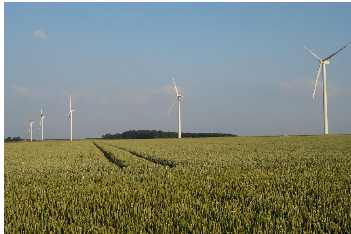
Photo 2 : vue générale d'un parc éolien en plaine (VALOREM)
