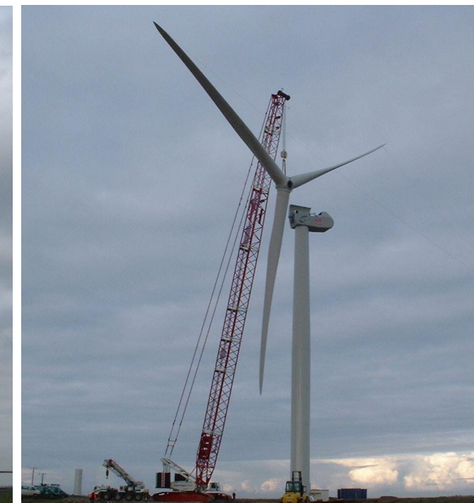
Montage du rotor
