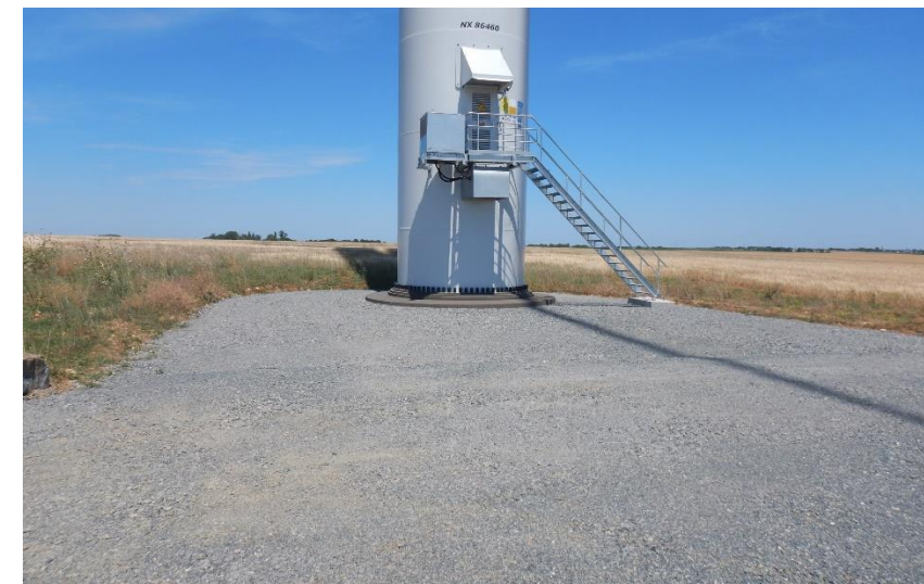
Photo 22 : plateforme au pied d'une éolienne
