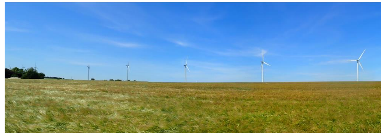
Photo 14 : parc éolien d'Aubigeon
